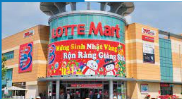
CUNG CẤP THI CÔNG LẮP ĐẶT GIẢI PHÁP TÍCH KIỆM ĐIỆN NĂNG SIÊU THỊ LOTTE
