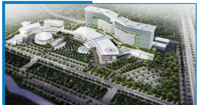
THI CÔNG LẮP ĐẶT HỆ THỐNG M&E BỆNH VIỆN BÌNH DƯƠNG
