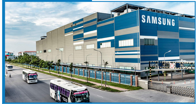
THI CÔNG HỆ THỐNG SCANDAR NHÀ MÁY XỬ LÝ NƯỚC THẢI SAMSUNG 1 THÁI NGUYÊN
