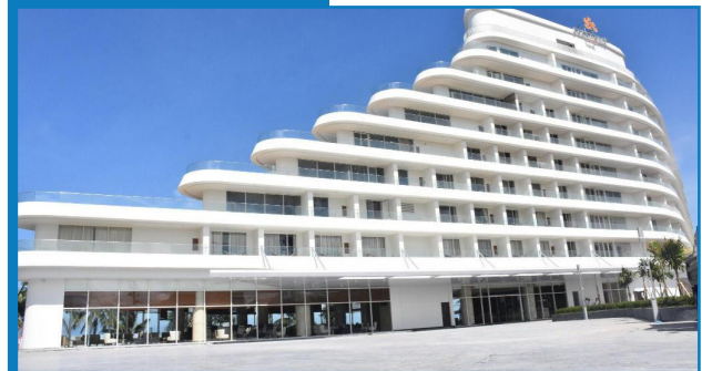
THI CÔNG CẢI TẠO HỆ THỐNG M&E HUƠNG BIỂN HOTEL - PHÚ QUỐC, KIÊN GIANG
