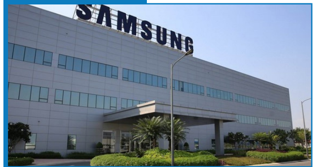
THI CÔNG LẮP ĐẶT HỆ THỐNG XỬ LÝ NƯỚC THẢI NHÀ MÁY SAMSUNG HCM
