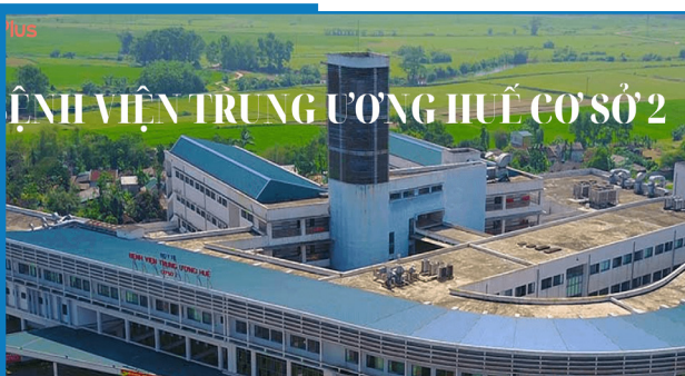
THI CÔNG HỆ THỐNG BMS BỆNH VIỆN TRUNG ƯƠNG HUẾ
