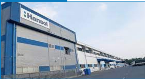
THI CÔNG LẮP ĐẶT HỆ THỐNG CƠ - ĐIỆN LẠNH VÀ TỰ ĐỘNG HÓA NHÀ MÁY HANSOL THÁI NGUYÊN
